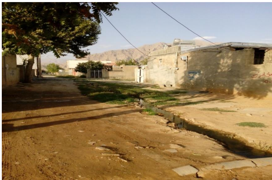
عکس ۱- عدم وجود معابر نامناسب در کرناچی
